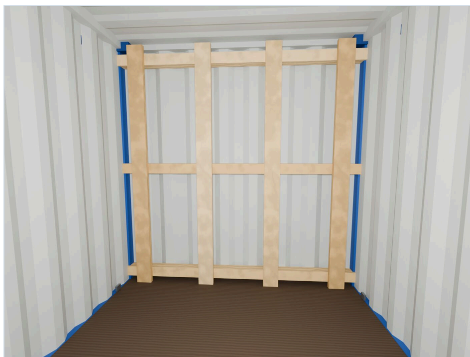
阶段照片 04 端墙挡板：3根100×100方木贴墙、端头嵌入波纹，其上钉4根竖板
