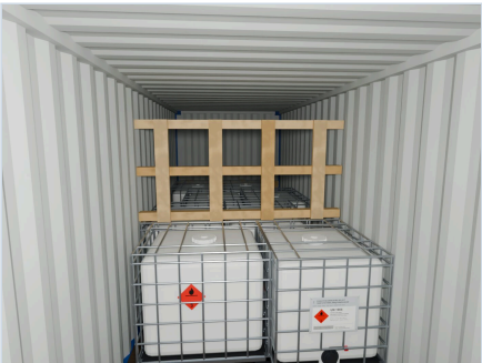
09 端墙侧第二层挡板：3根方木（6号件），4根立柱（10号件） 从箱门方向、在第一层上方约2.2米高度拍摄：第二层挡板全貌——3根方木、4根立柱，方木端头嵌入波纹。
